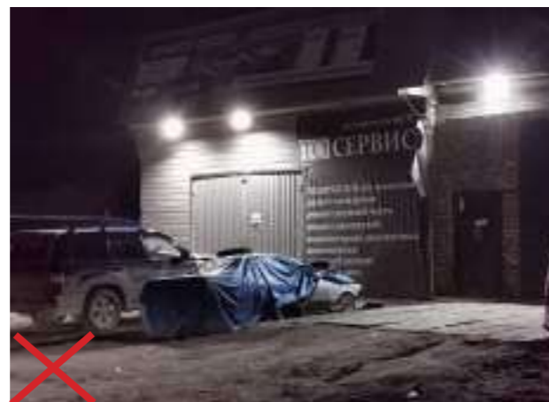
Недопустимо устанавливать светильники (прожекторы) со слепящим эффектом.
